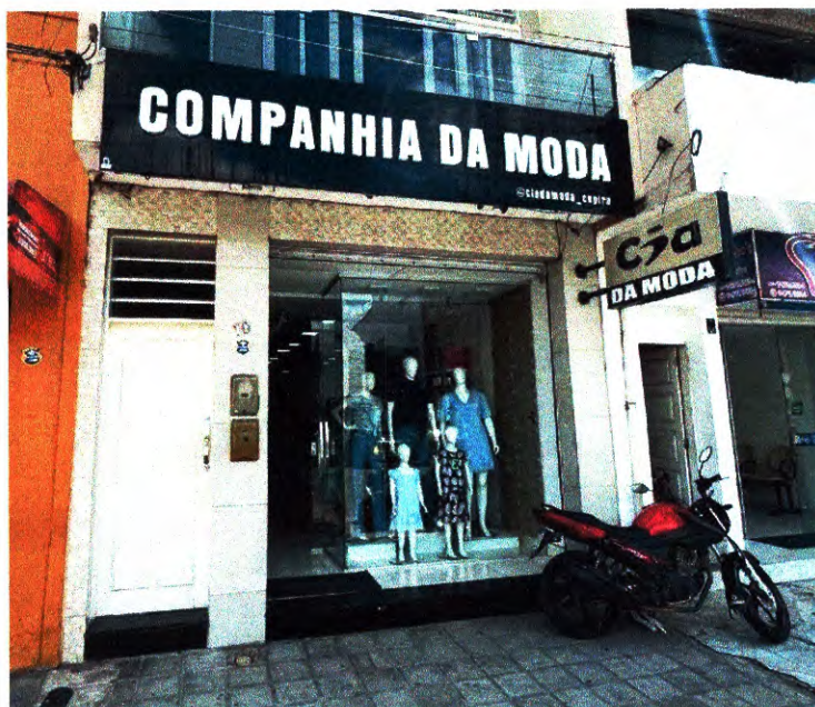
Imagem 2: Fachada do Prédio Vistoriado.
