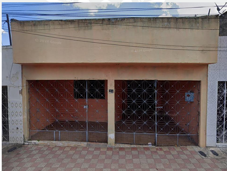
Imagem 2: Fachada do Prédio Vistoriado.
