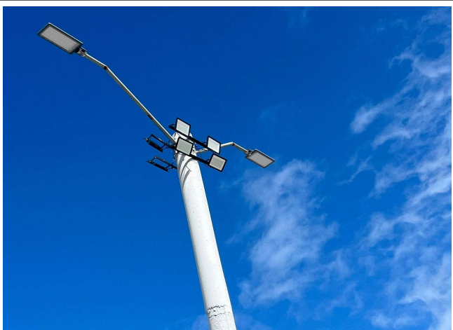
FOTO 3: INSTALAÇÃO DE REFLETORES NA QUADRA DE AREIA
