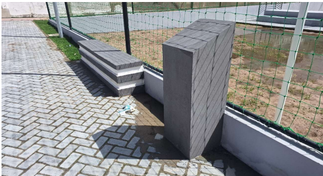
FOTO 40: APLICAÇÃO DE CIMENTO QUEIMADO NO TOTEM
