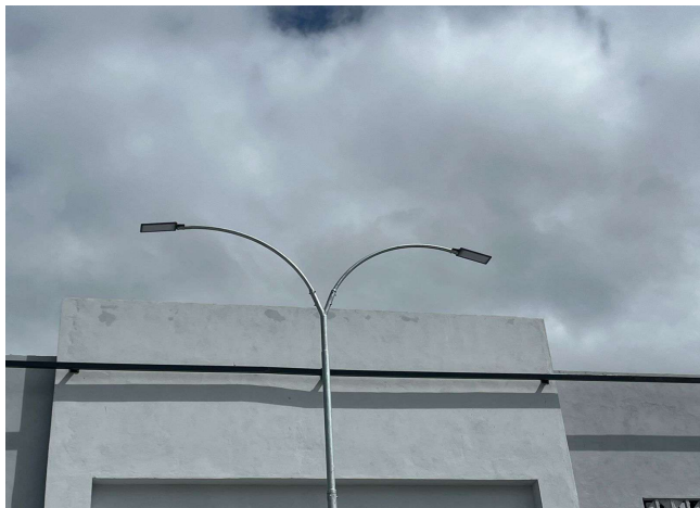
FOTO 7: | INSTALAÇÃO DE LUMINARIAS NOS POSTES
