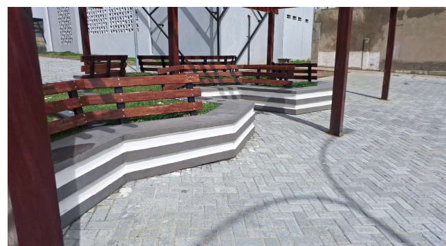
FOTO 11: | PINTURA E APLICAÇÃO DE CIMENTO QUEIMADO DO BANCO
