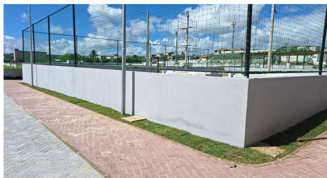
FOTO 30: EXECUÇÃO DE PINTURA NOS MUROS DA QUADRA DE AREIA
