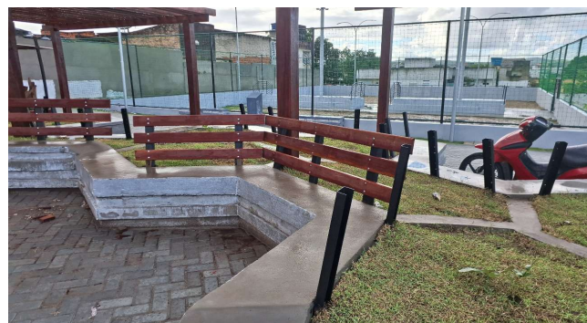
FOTO 19: INSTALAÇÃO DE MADEIRA PARA ENCOSTO DO BANCO
