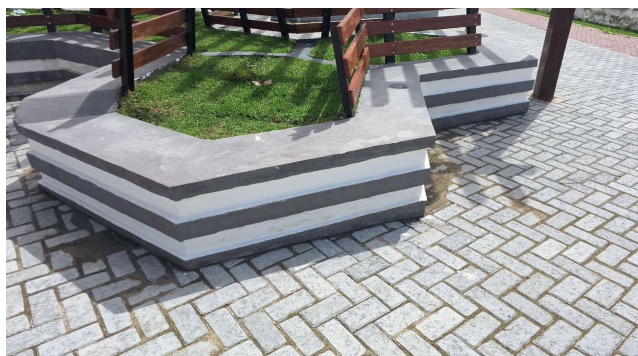
FOTO 12: | PINTURA E APLICAÇÃO DE CIMENTO QUEIMADO DO BANCO
