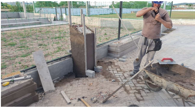
FOTO 37: EXECUÇÃO DE TOTEM
