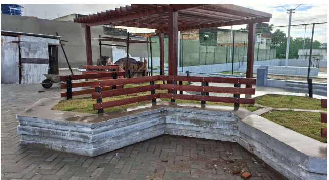
FOTO 20: INSTALAÇÃO DE MADEIRA PARA ENCOSTO DO BANCO
