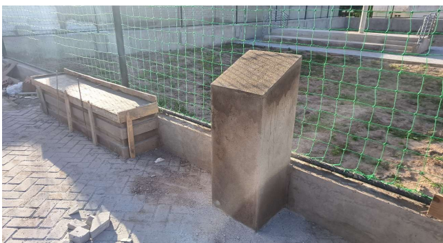
FOTO 38: EXECUÇÃO DE REBOCO DO TOTEM
