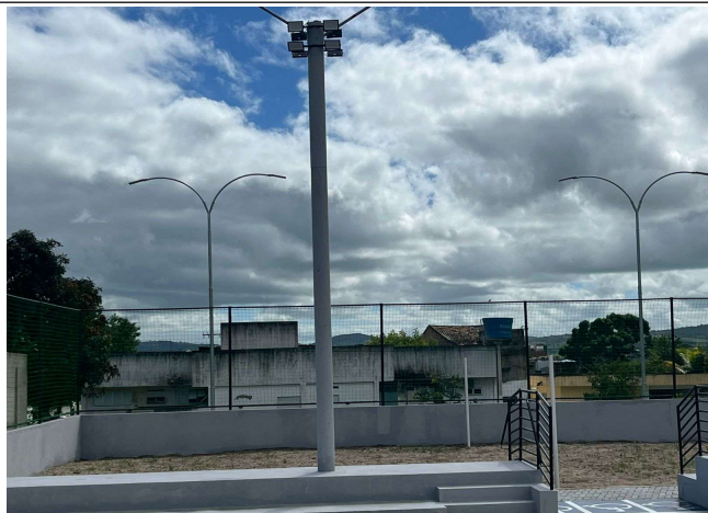
FOTO 1: POSTES DE CONCRETO
