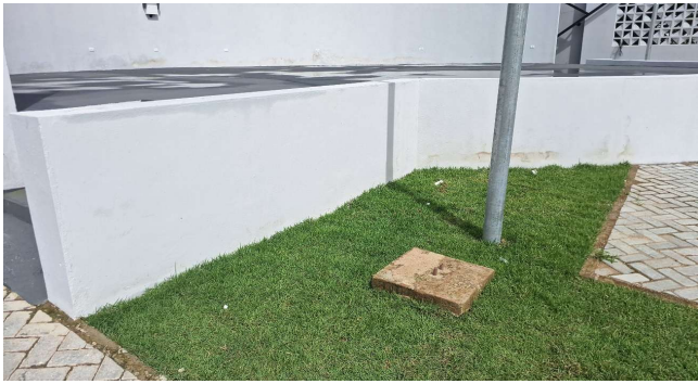
FOTO 36: PINTURA DO MURO DO ANFITEATRO
