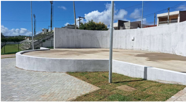
FOTO 35: PINTURA DO MURO DO ANFITEATRO
