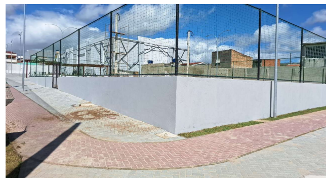
FOTO 29: EXECUÇÃO DE PINTURA NOS MUROS DA QUADRA DE AREIA
