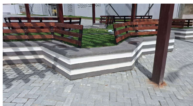
FOTO 14: | PINTURA E APLICAÇÃO DE CIMENTO QUEIMADO DO BANCO
