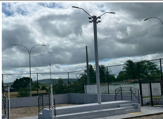
FOTO 2: POSTES DE CONCRETO
