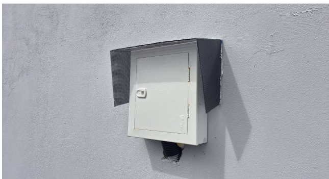
FOTO 9: | INSTALAÇÃO DE QUADRO DE DISTRIBUIÇÃO
