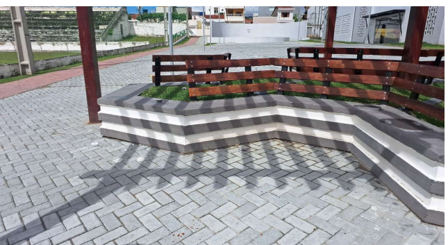
FOTO 13: | PINTURA E APLICAÇÃO DE CIMENTO QUEIMADO DO BANCO
