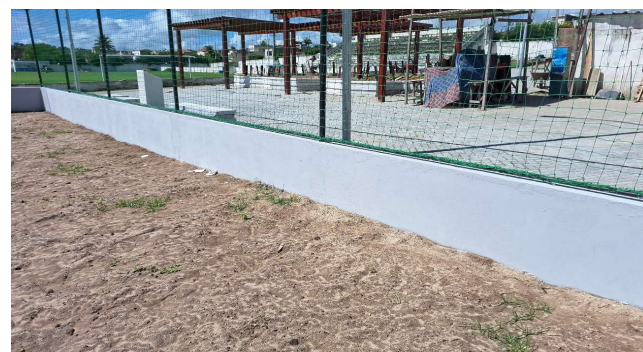
FOTO 32: EXECUÇÃO DE PINTURA NOS MUROS DA QUADRA DE AREIA
