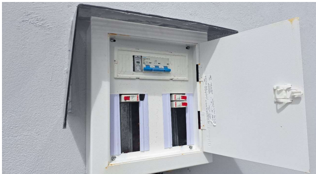
FOTO 10: | INSTALAÇÃO DE DISJUNTORES E DPS
