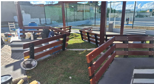
FOTO 18: INSTALAÇÃO DE MADEIRA PARA ENCOSTO DO BANCO
