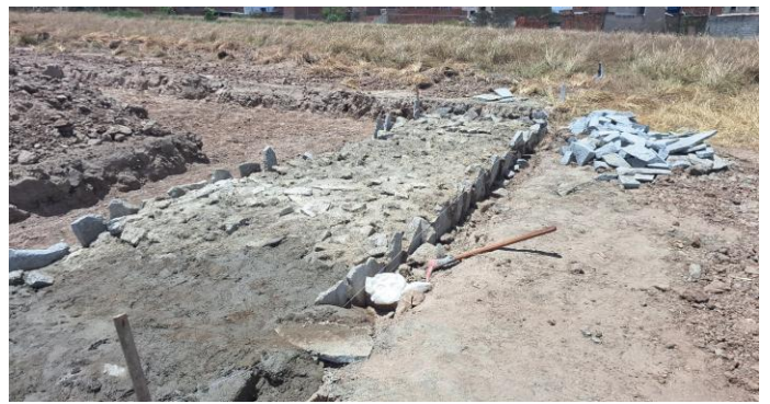
FOTO 16: |EXECUÇÃO DO MURO DE CONTENÇÃO
