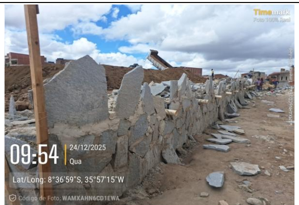
FOTO 22: |EXECUÇÃO DO MURO DE CONTENÇÃO
