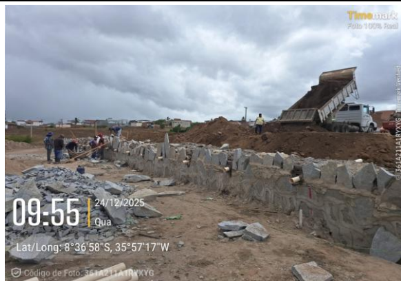
FOTO 1: ATERRO MECANIZADO
