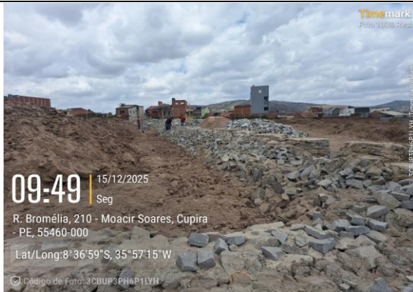
FOTO 19: |EXECUÇÃO DO MURO DE CONTENÇÃO
