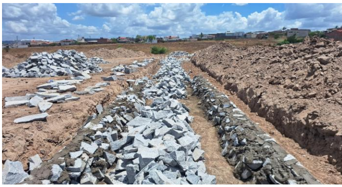
FOTO 15: |EXECUÇÃO DO MURO DE CONTENÇÃO
