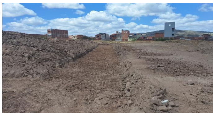
FOTO 9: | ESCAVAÇÃO MECANIZADA DE VALA
