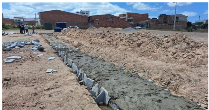
FOTO 12: | EXECUÇÃO DO MURO DE CONTENÇÃO
