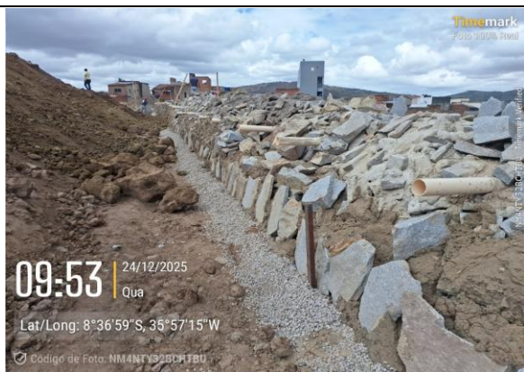
FOTO 25: ENCHIMENTO DE BRITA PARA DRENO
