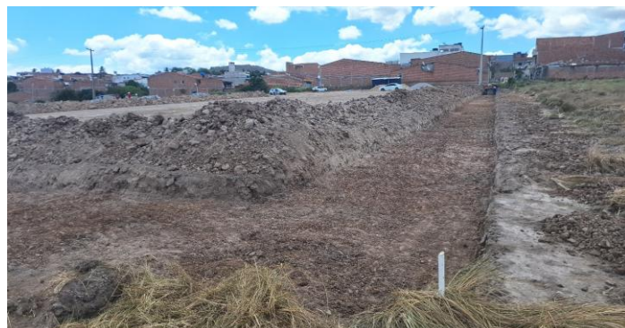
FOTO 10: | ESCAVAÇÃO MECANIZADA DE VALA
