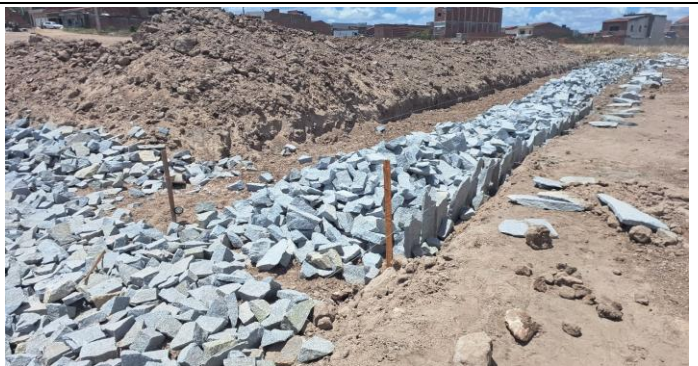
FOTO 14: | EXECUÇÃO DO MURO DE CONTENÇÃO
