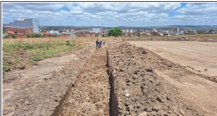
FOTO 7: | ESCAVAÇÃO MECANIZADA DE VALA
