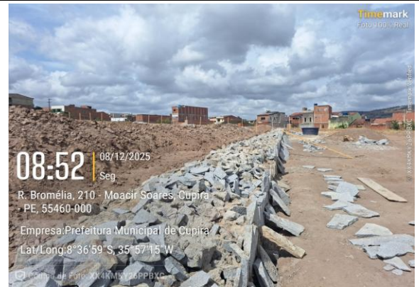
FOTO 18: |EXECUÇÃO DO MURO DE CONTENÇÃO
