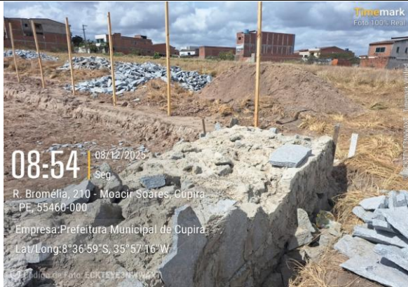
FOTO 17: |EXECUÇÃO DO MURO DE CONTENÇÃO
