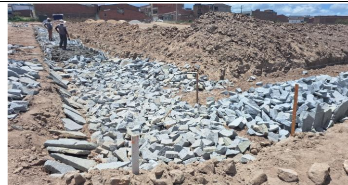
FOTO 13: | EXECUÇÃO DO MURO DE CONTENÇÃO
