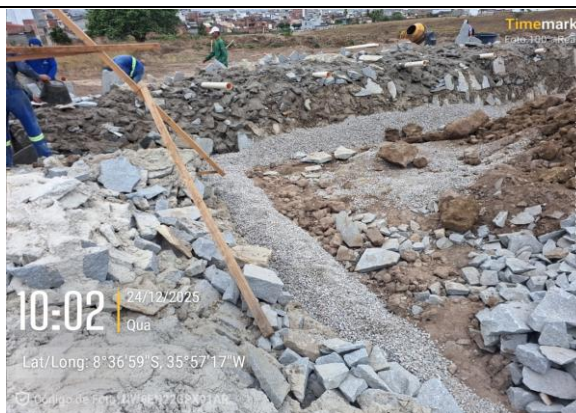
FOTO 26: ENCHIMENTO DE BRITA PARA DRENO
