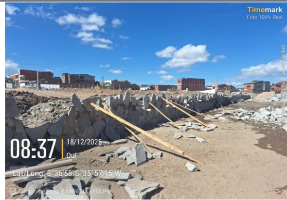
FOTO 20: |EXECUÇÃO DO MURO DE CONTENÇÃO
