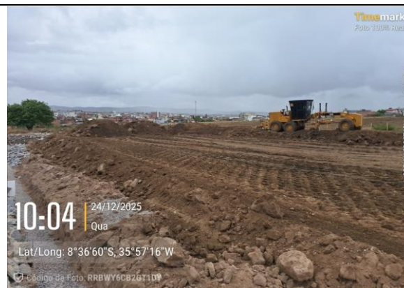
FOTO 4: ATERRO MECANIZADO
