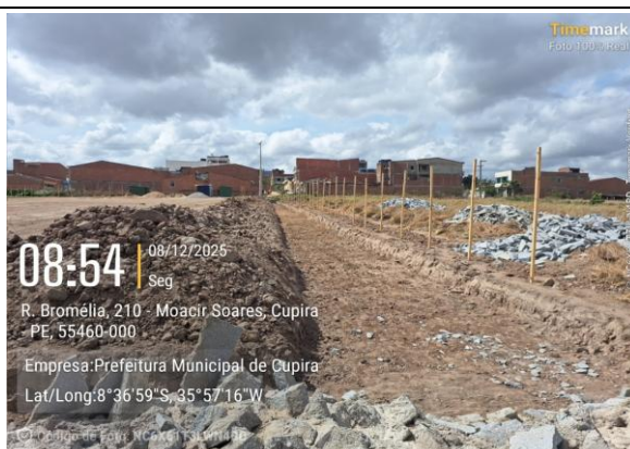
FOTO 6: ESCAVAÇÃO MECANIZADA DE VALA
