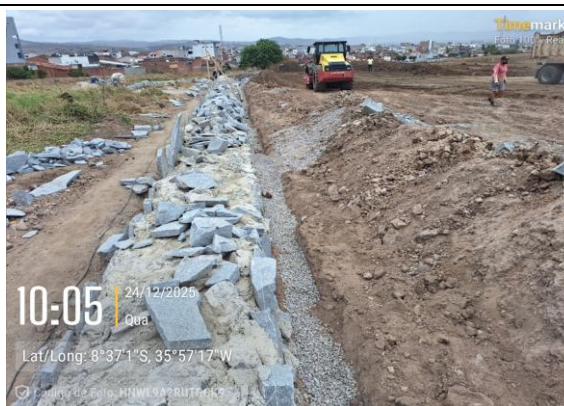
FOTO 24: EXECUÇÃO DO MURO DE CONTENÇÃO E ENCHIMENTO DE BRITA
