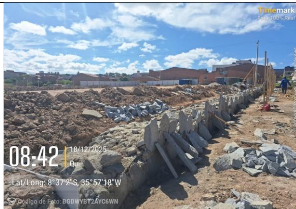
FOTO 21: |EXECUÇÃO DO MURO DE CONTENÇÃO
