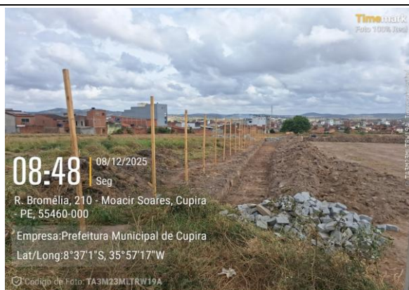
FOTO 5: ESCAVAÇÃO MECANIZADA DE VALA
