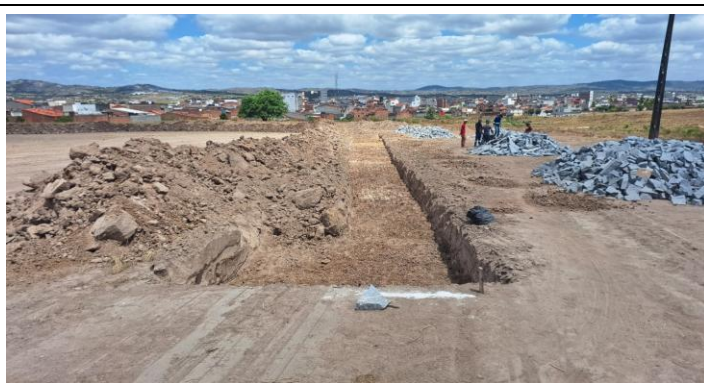
FOTO 8: | ESCAVAÇÃO MECANIZADA DE VALA
