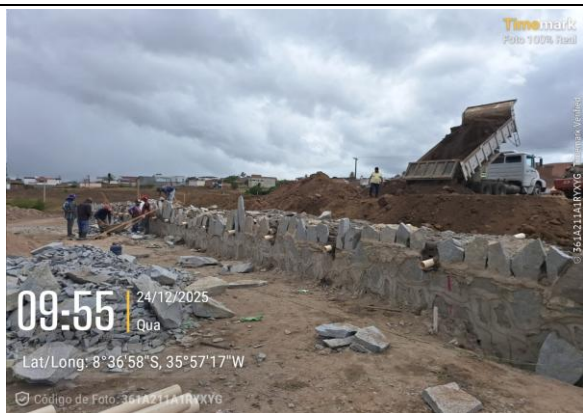
FOTO 23: EXECUÇÃO DO MURO DE CONTENÇÃO
