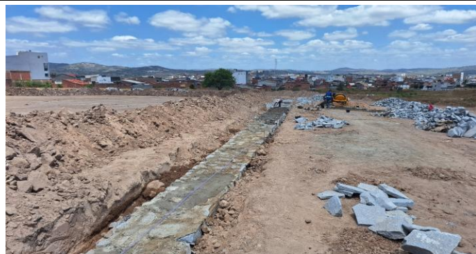
FOTO 11: | EXECUÇÃO DO MURO DE CONTENÇÃO
