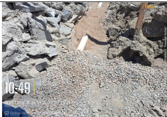
FOTO 27: ENCHIMENTO DE BRITA PARA DRENO
