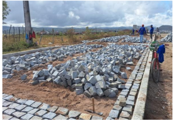
FOTO 24: EXECUÇÃO DE PAVIMENTO EM PARALELEPÍPEDOS
