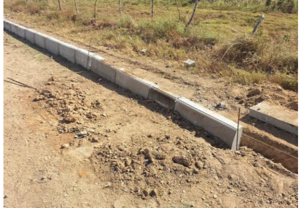
FOTO 16: ASSENTAMENTO DE GUIA (MEIO-FIO)
