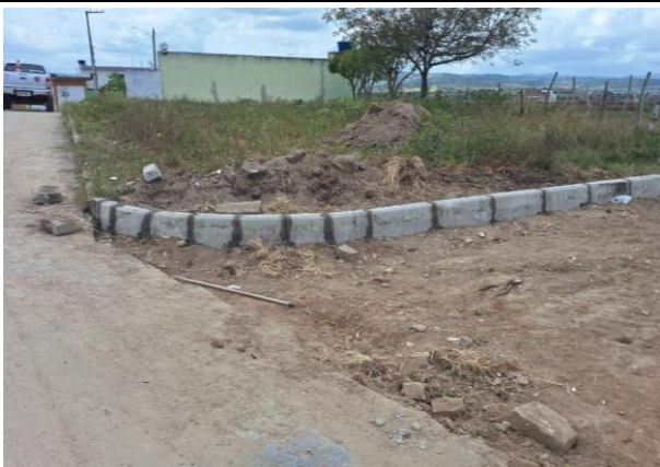
FOTO 11: ASSENTAMENTO DE GUIA (MEIO-FIO)
