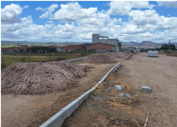
FOTO 17: ASSENTAMENTO DE GUIA (MEIO-FIO)
