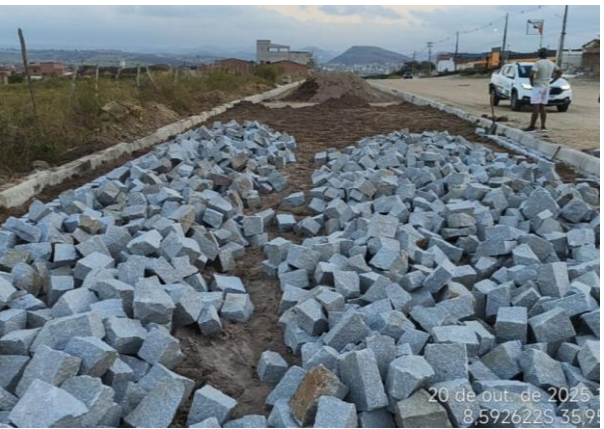
FOTO 19: EXECUÇÃO DE PAVIMENTO EM PARALELEPÍPEDOS
