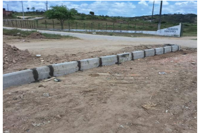
FOTO 18: ASSENTAMENTO DE GUIA (MEIO-FIO)
