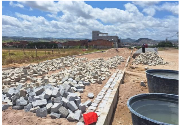
FOTO 22: EXECUÇÃO DE PAVIMENTO EM PARALELEPÍPEDOS
