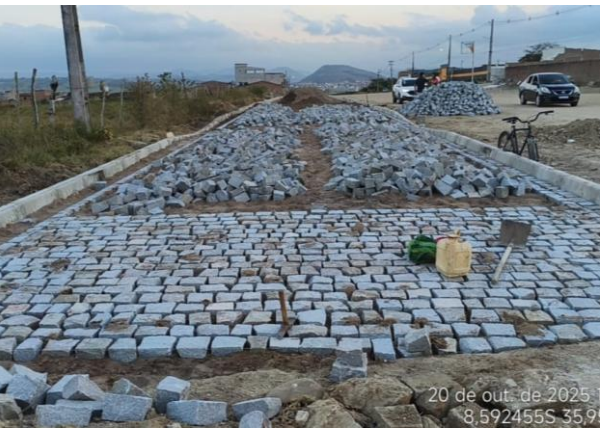
FOTO 21: EXECUÇÃO DE PAVIMENTO EM PARALELEPÍPEDOS
