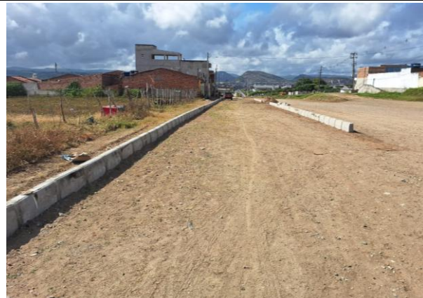
FOTO 14: ASSENTAMENTO DE GUIA (MEIO-FIO)
