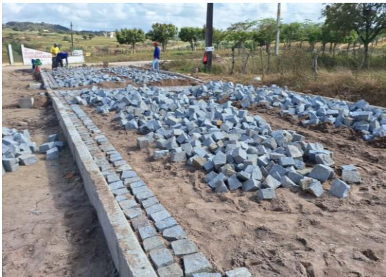
FOTO 25: EXECUÇÃO DE PAVIMENTO EM PARALELEPÍPEDOS
