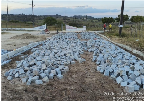
FOTO 20: EXECUÇÃO DE PAVIMENTO EM PARALELEPÍPEDOS
