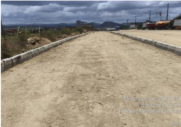
FOTO 15: ASSENTAMENTO DE GUIA (MEIO-FIO)
