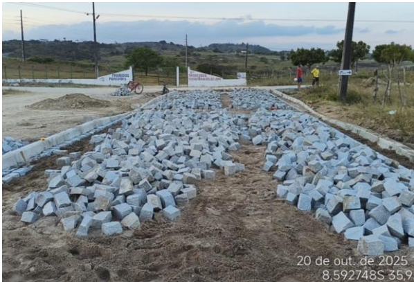
FOTO 23: EXECUÇÃO DE PAVIMENTO EM PARALELEPÍPEDOS
