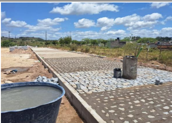
FOTO 29: EXECUÇÃO DE PAVIMENTO EM PARALELEPÍPEDOS
