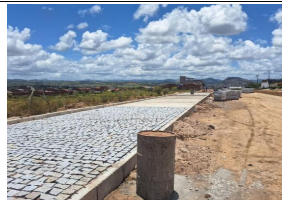
FOTO 30: EXECUÇÃO DE PAVIMENTO EM PARALELEPÍPEDOS
