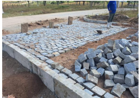
FOTO 26: EXECUÇÃO DE PAVIMENTO EM PARALELEPÍPEDOS
