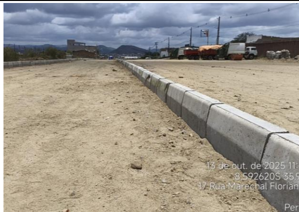
FOTO 12: ASSENTAMENTO DE GUIA (MEIO-FIO)
