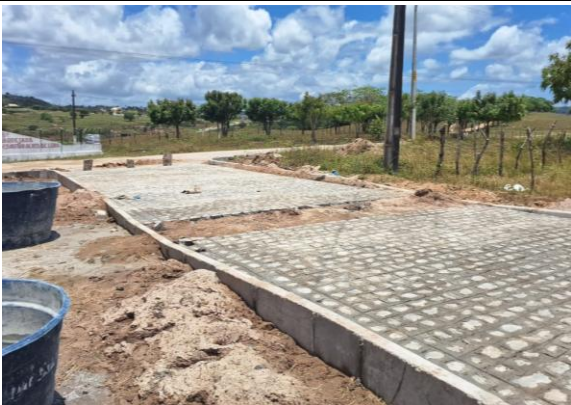
FOTO 27: EXECUÇÃO DE PAVIMENTO EM PARALELEPÍPEDOS
