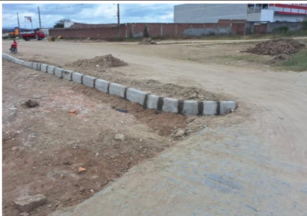
FOTO 13: ASSENTAMENTO DE GUIA (MEIO-FIO)
