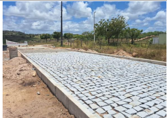
FOTO 28: EXECUÇÃO DE PAVIMENTO EM PARALELEPÍPEDOS
