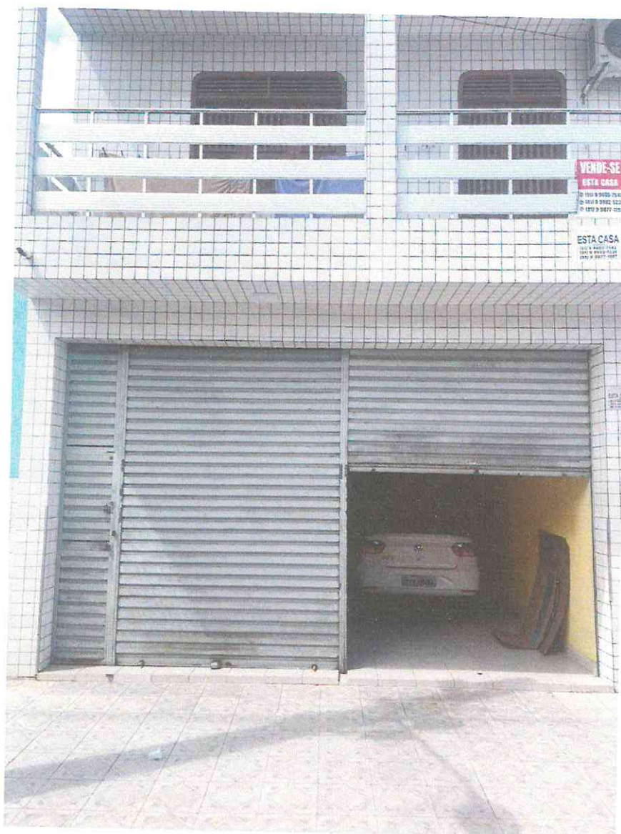
Imagem 2: Fachada do Prédio Vistoriado.
