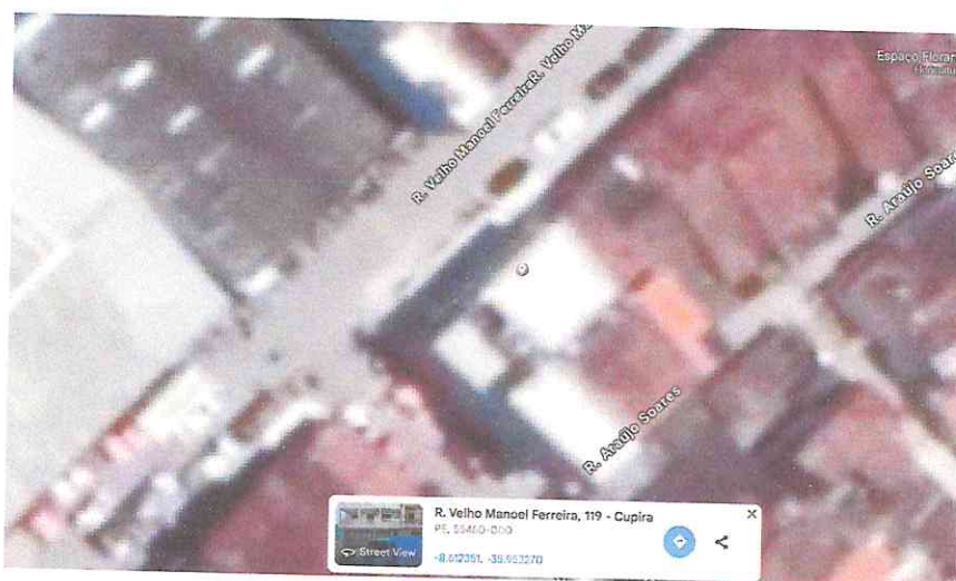
Imagem 1: Localização do Prédio Vistoriado.
