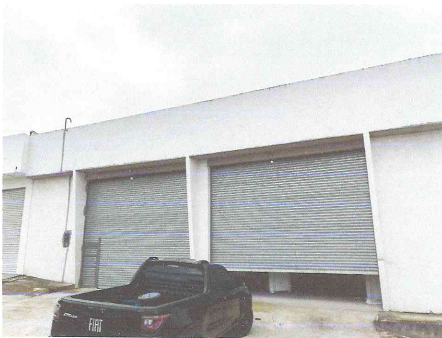
Imagem 2: Fachada do Prédio Vistoriado.
