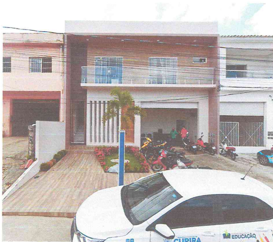
Imagem 2: Fachada do Prédio Vistoriado.
